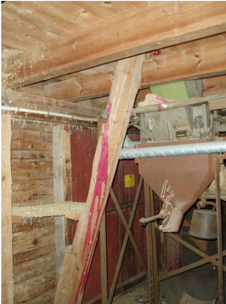
Bild 7. Kvicksilvret från betning av säd syns ofta tydligt då det rödfärgar byggnadsmaterialet.
