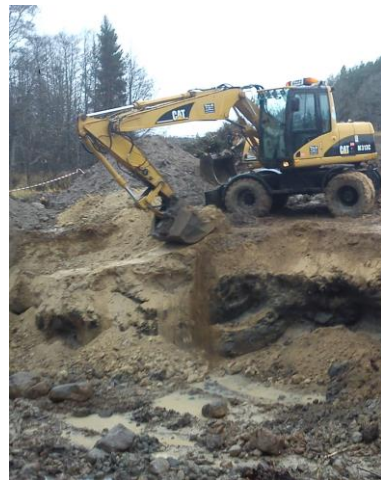
Bild 2. PCB-deponin under sanering
