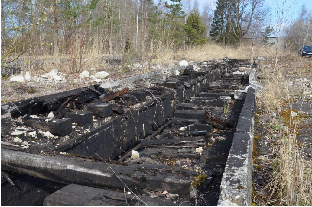
Attēls Nr. 3 Dzelzceļa estakādes pazīmes ar redzamiem mazuta nolijumiem.
