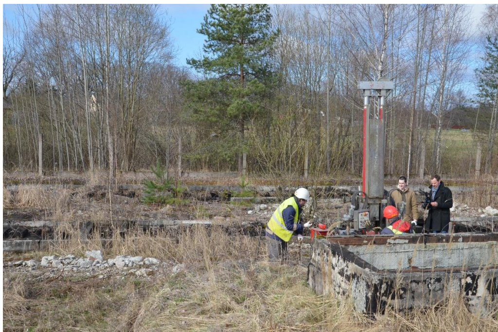
Attēls Nr. 6 Testa urbuma ierīkošana augsta piesārņojuma riska zonā – starp estakādi un pieņemšanas kameru
