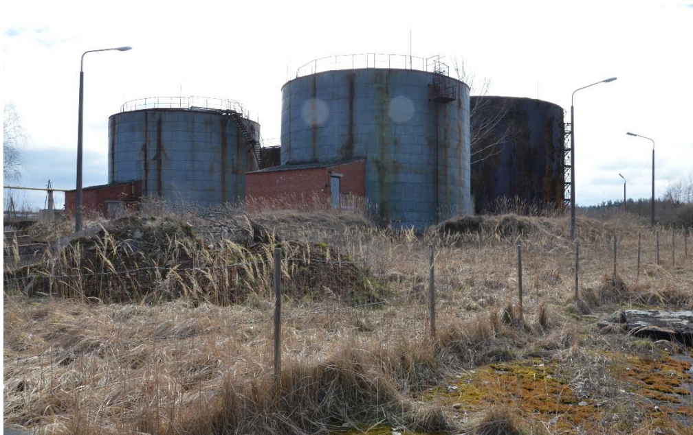
Attēls Nr. 2 Mazuta uzglabāšanas tvertnes
