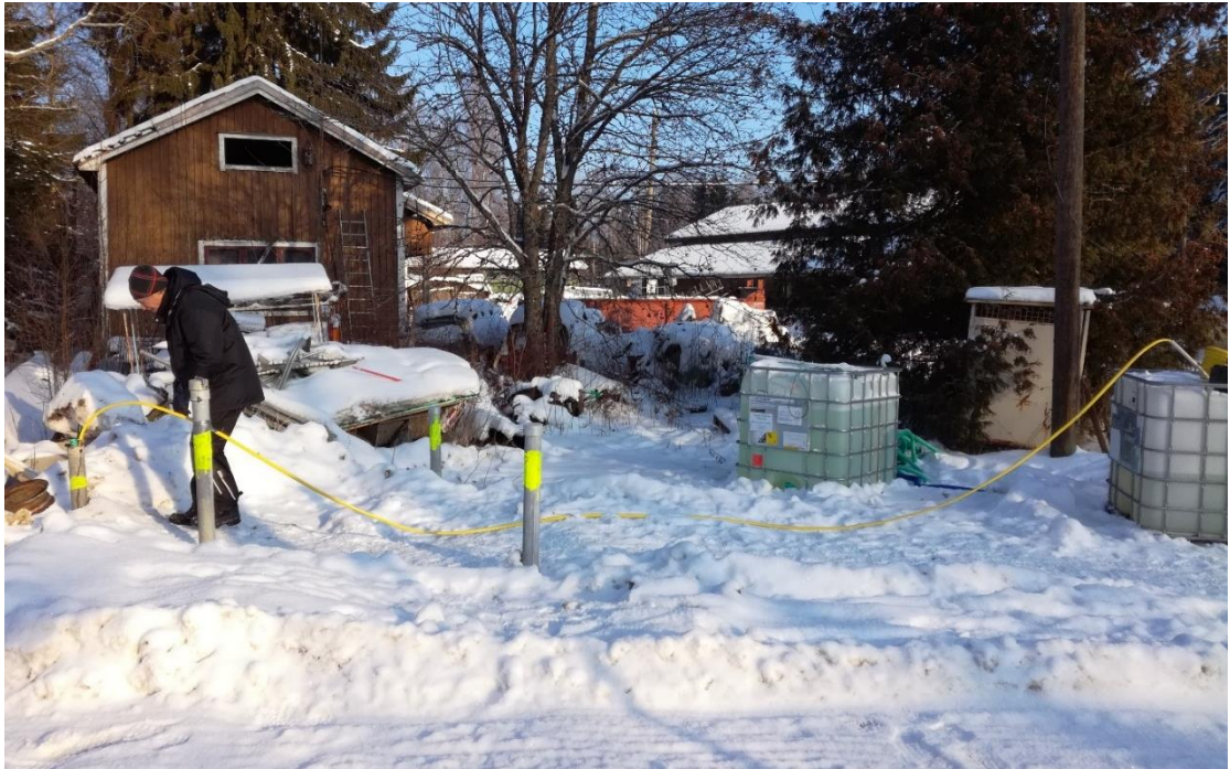
Liite 6. Laimennettua vetyperoksidia syötettiin IBC-säiliöstä pohjavesiputkeen käyttäen tavallista puutarhaletkua sekä pilssipumppua.
