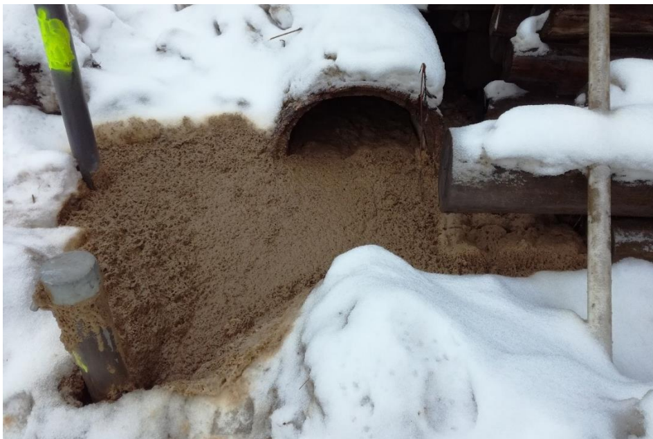
Liite 7. Talven viimeisen syöttökerran jälkeen vetyperoksidia vaahtosi maan pinnalle n. 3 metrin päähän syöttöputkesta, osittain kuvassa näkyvien parrujen alle. Kulkusuunta oli pois päin koealueesta, oletetun pohjaveden virtaussuunnan mukaisesti.
