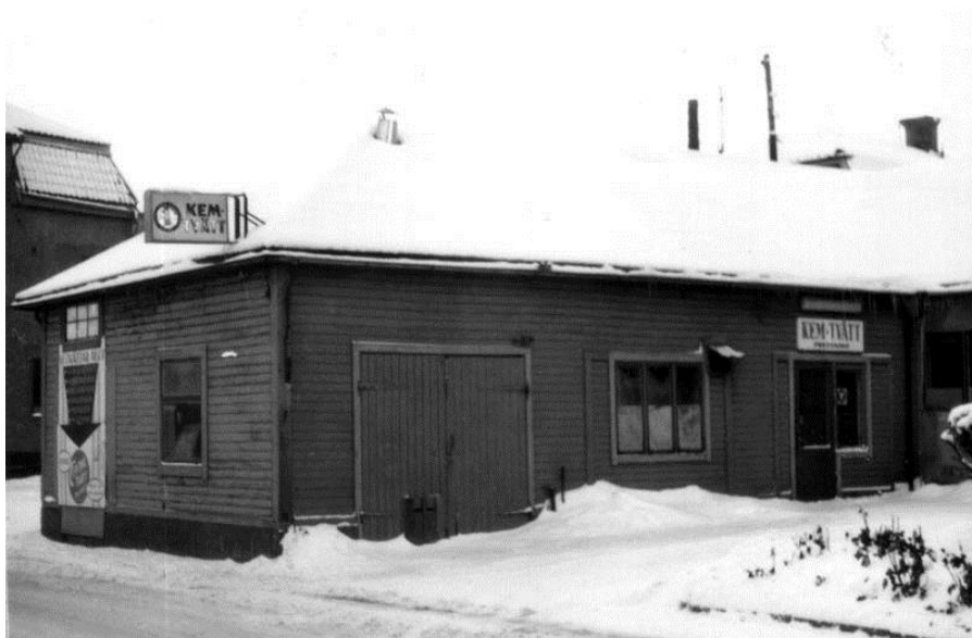
Figur 21. Här låg kemtvätten. Bygganden är sedan länge riven.
