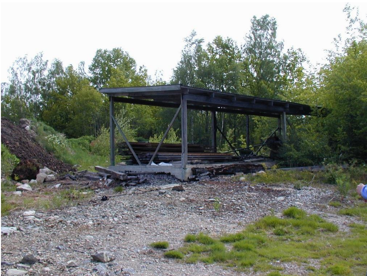
Figur 22. Impregneringsplatsen vid Brenäs sågverk.
