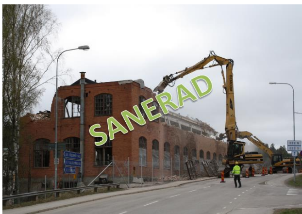
Figur 23. Rivning av byggnaderna vid Gusums bruk.
